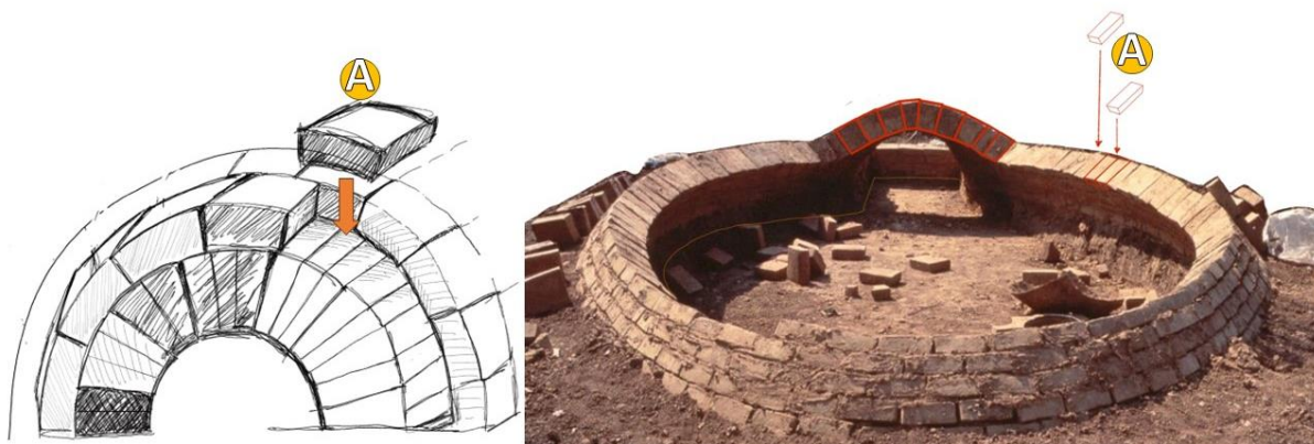
รูปที่ 9 โครงสร้างเตาฟืนดินเหนียวรูปแบบใหม่
