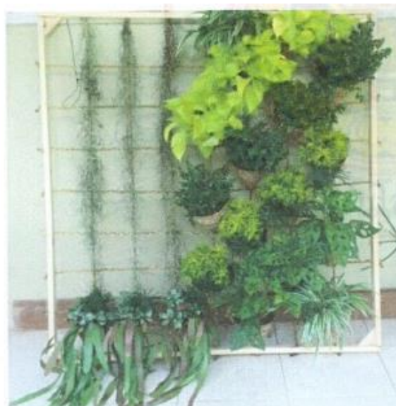
รูปที่ 11 ต้นแบบผนังเขียวจากกาบกล้วย
