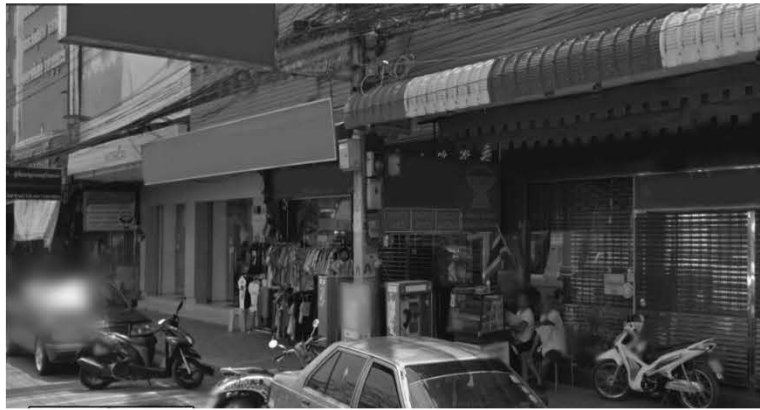
รูปที่ 2 แสดงลักษณะของป้ายโฆษณาบริเวณถนนราชดำเนิน ที่มีลักษณะไม่สอดคล้องกับกฎกระทรวง ฉบับที่ 55 และ พรบ. ควบคุมอาคาร พ.ศ. 2522
