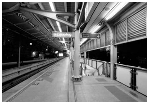
รูปที่ 10 รูปตัวอย่างที่ 4 ชานชาลาสถานีรถไฟฟ้า BTS สถานีสะพานตากสิน
