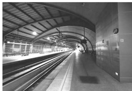
รูปที่ 7 รูปตัวอย่างที่ 1 ชานชาลาสถานีรถไฟฟ้าแอร์พอร์ตลิงค์ สถานีลาดกระบัง
