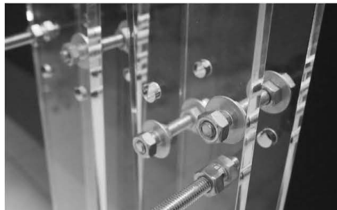
รูปที่ 4.14-4.15 น็อตขนาด 3" ตัวผู้ ตัวเมียและแหวนเพื่อยึดแผ่นอะคริลิก และลักษณะการยึดแผ่นอะคริลิกด้วยน็อต ที่มา: ผู้วิจัย (5 พ.ค. 55)
