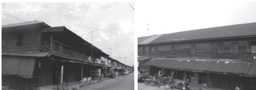
รูปที่ 3 กลุ่มอาคารเรือนแถวไม้ค้าขายบริเวณริมคลองภาษีเจริญทางด้านทิศเหนือ ที่มา: จากการสำรวจโดยผู้วิจัย
