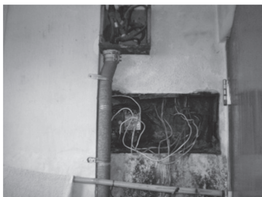
รูปที่ 5 แสดงสภาพตู้เมนสวิตช์ในระบบไฟฟ้าของโถงนิทรรศการหลัก
