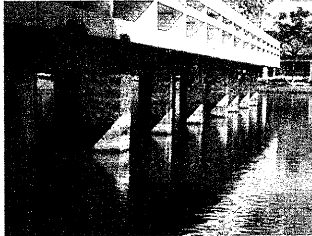
รูปที่ 6 เสาตอม่อที่อยู่ใต้น้ำต่ำกว่าระดับน้ำอยู่เดิมและ/หรือมาประสบปัญหาน้ำท่วมขังหลังจากใช้อาคาร (อาคาร 1 ในสถาบันเทคโนโลยีพระจอมเกล้าเจ้าคุณทหารลาดกระบัง)
