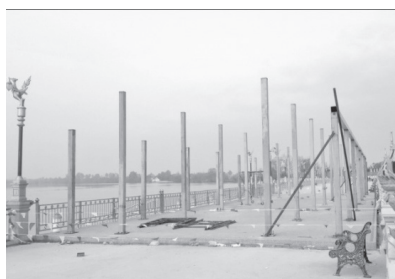
1) งานติดตั้งเสาเหล็ก 150x150x3.2 มม.
