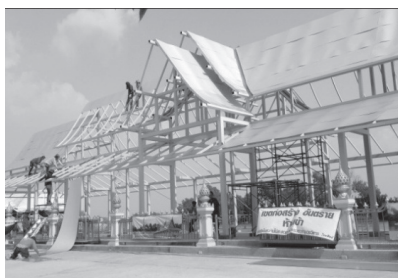
5) ติดตั้งแผ่นเหล็กกันรั่ว
