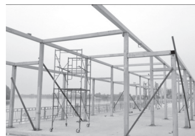
3) ประกอบโครงสร้างเสาและคานเหล็ก
