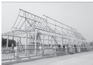
4) ติดตั้งโครงสร้างหลังคาเหล็ก
