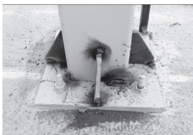
2) เชื่อมรอยต่อฐานเสายึดบนพื้นค.ส.ล.
