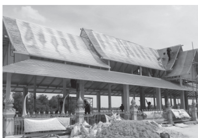
8) ติดตั้งแปเหล็กหลังคา
