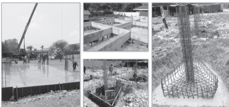
รูปที่ 4 จากซ้ายการเทพื้นชั้นใต้ถุน โครงสร้างคานระดับพื้นชั้นหนึ่ง 1.20 เมตร และขนาดเสาตอม่อ ที่มา: ผู้วิจัย (2556 - 2557)
