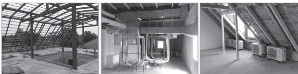
รูปที่ 6 โครงหลังคาเป็นโครงสร้างหลัก มีพื้นที่ภายในห้องใต้หลังคาเพื่อวางงานระบบ ที่มา: ผู้วิจัย (2558)
