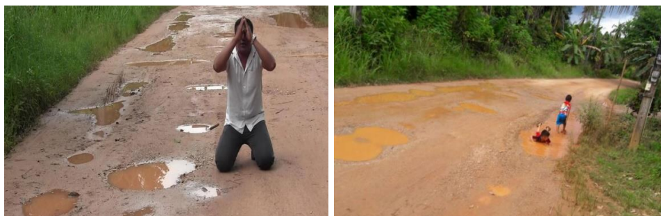
ถนนสายควนไม่แดง-พุดเตียว ต.เขาหิน อ.เขาพนม จ.กระบี่ พ.ศ. 2559
