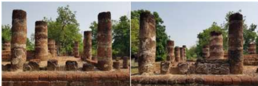
ภาพที่ 12 แนวราวลูกกรงกันตก ตามแนวเสาชั้นนอก โดยรอบอาคารพระมณฑปประธานวัดตระพังช้างเผือก
