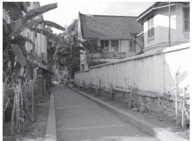
สภาพบ้านเรือนในเขตอนุรักษ์มรดกโลกจำนวนมากที่ทรุดโทรม แต่ไม่สามารถซ่อมแซมให้เป็นไปตามแบบของสำนักงานมรดกโลกได้ เพราะต้องใช้เงินซื้อกระเบื้องมุงหลังคา จึงปล่อยทิ้งสภาพเดิมไว้ก่อน
