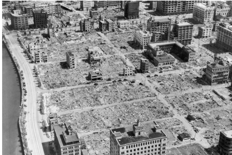
ภาพที่ 1 ภาพถ่ายทางอากาศเมืองโตเกียว 1945 จากเหตุทิ้งระเบิด
