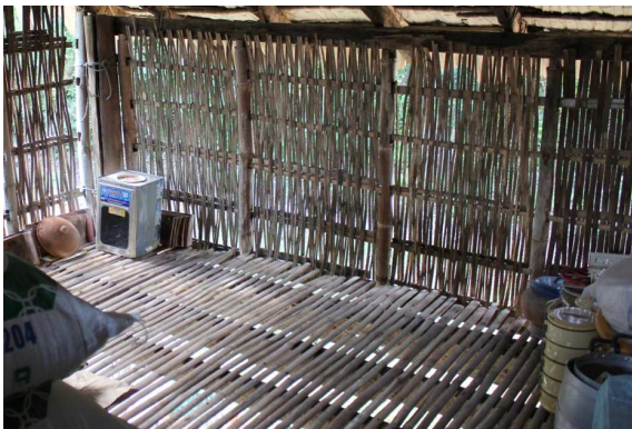
ภาพที่ 3 ฝาไม้ไผ่ขัดแตะ มุมมองจากภายในเรือนออกสู่ภายนอก
