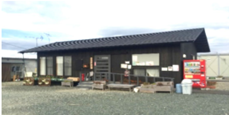
ภาพที่ 1 อาคารส่วนกลางภายในชุมชนบ้านพักชั่วคราวในจังหวัดคุเมะโตะ ภาพถ่ายโดยนักวิจัย เมื่อวันที่ 14 ธันวาคม 2560
