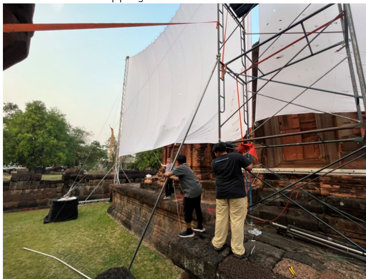
ภาพที่ 6 การติดตั้งโครงสร้างเหล็กและฉากผ้าขาวบาง
