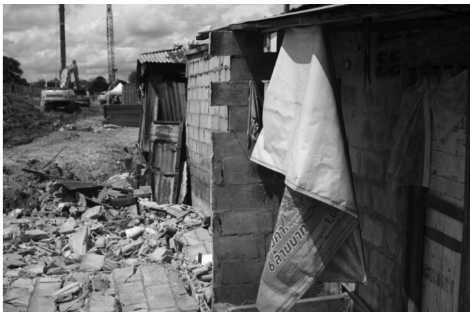
ภาพที่ 2 การรื้อถอนบ้านที่อยู่ข้างทางรถไฟเพื่อขยายสร้างรถไฟรางคู่ จาก “ชุมชนริมทางรถไฟขอนแก่นเสี่ยงเป็นคนไร้บ้านหลังถูกไล่รื้อที่อยู่อาศัย” โดย “อีสานเรคคอร์ด”
