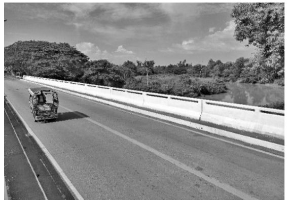
ภาพที่ 5 สะพานข้ามลำน้ำห้วยหลวง
